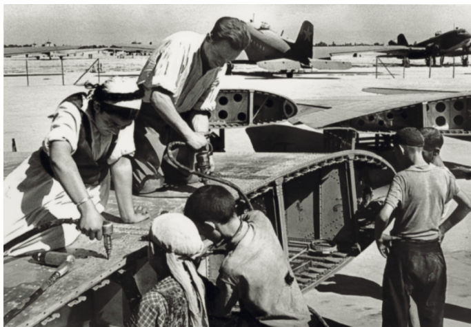
Рис. 15. Постройка первых ПС-84 велась под открытым небом
