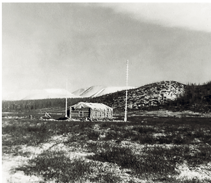
Рис. 13. Здание радиостанции на маршруте Аляска-Сибирь
