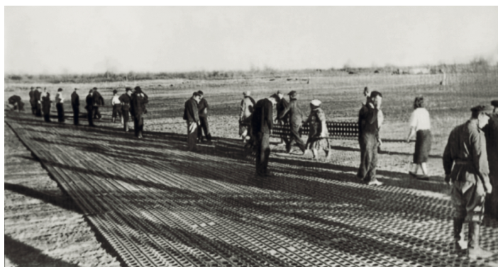
Рис. 14. Строительство взлётно-посадочной полосы
