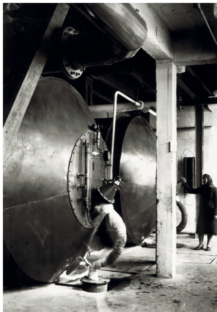
Рис. 5. Стационарные цистерны для хранения жидкого кислорода (емкостью 13,5 тонн) на Балашихинском кислородном заводе
