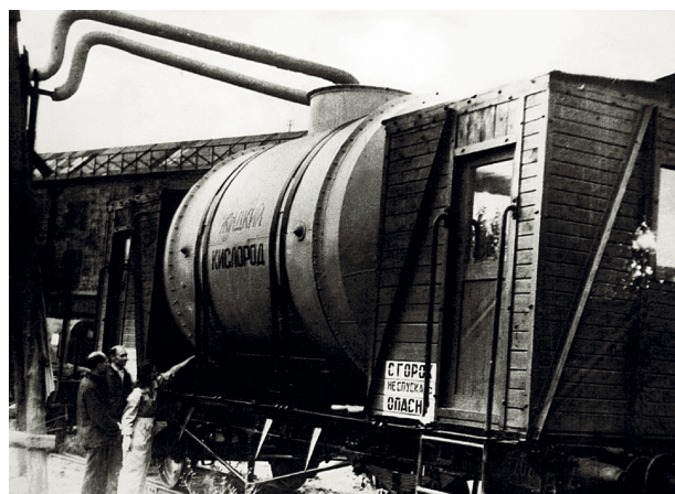
Рис. 7. Транспортировка жидкого кислорода в железнодорожных цистернах
