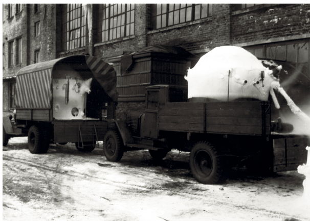
Рис. 6. Наполнение жидким кислородом транспортных танков (объемом 1000 куб. м) с помощью раздаточной колонки
