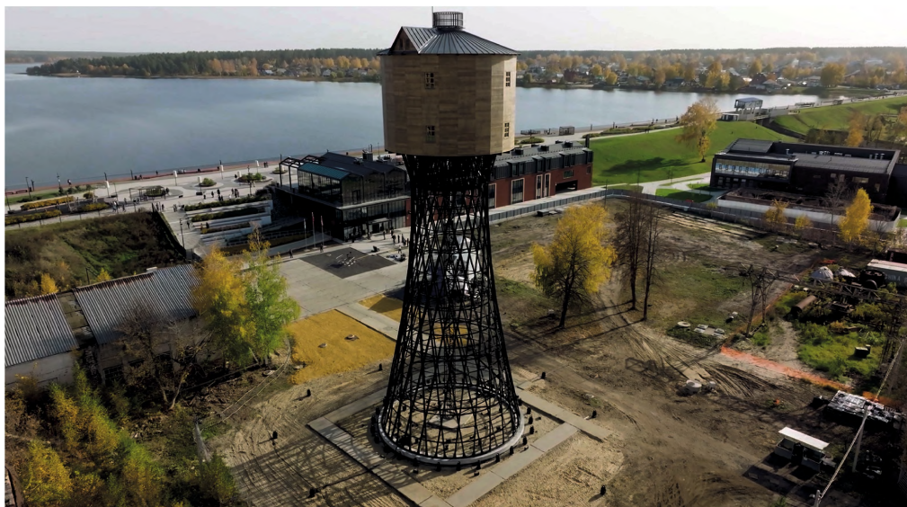
Рис. 5. Гиперboloидная водонапорная башня конструкции В.Г. Шухова в г. Выкса.
