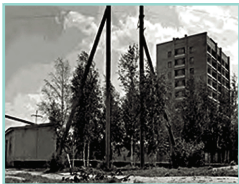
Рис. 6. Строительство первого дома для космонавтов. 1964 г.
