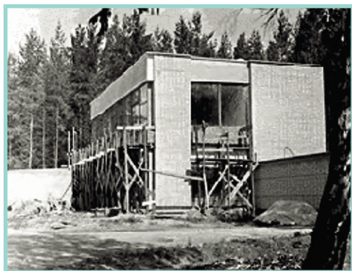
Рис. 4. Центральный контрольно-пропускной пункт в 1967 г.
