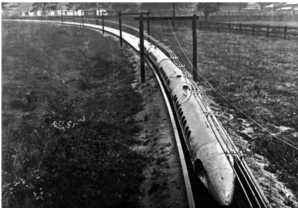
Рис. 4. Шаропоезд в 1/5 натуральной величины на испытательном полигоне вблизи пл. Северянин. 1933 г.
