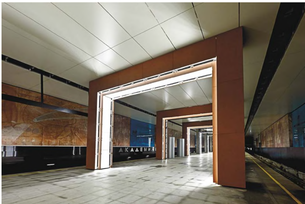
Рис. 1. Станция «Академическая» Троицкой линии Московского метрополитена. Источник: Технический пуск нового участка Троицкой линии метро от «Новаторской» до «ЗИЛа». 23 июня 2025 г. [Электронный ресурс]. Режим доступа: https://stroim.mos.ru/gallery/6985?utm_medium=organic&utm_source=yandexsmartcamera (дата обращения: 15.05.2026)
